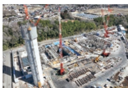
建設中の高浜クリーンセンター
