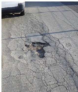
穴ぼこなどの改修を集中的に実施
