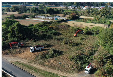
農業参入する企業による荒廃農地整備
