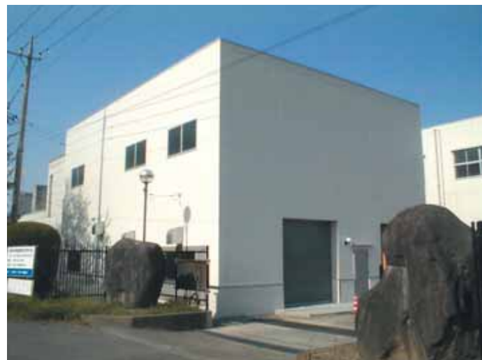
白川浄水場汚泥処理施設
