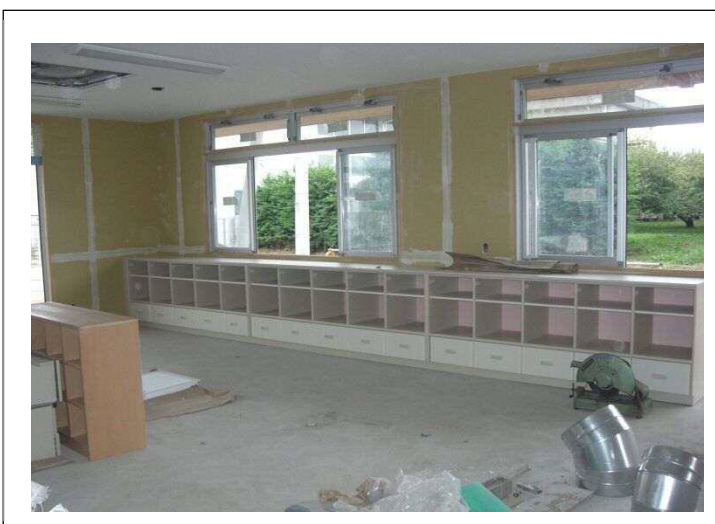
新園舎 保育室
