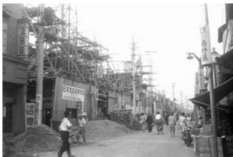
あら通りの拡張工事（昭和32年9月）
