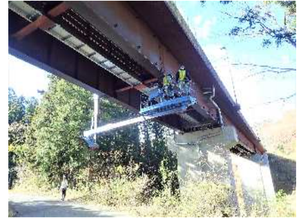
写真1 橋梁点検車による点検状況
