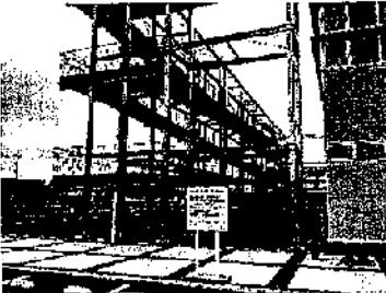
鉄骨造3階建て 耐火建築物
