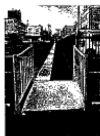
◎東町 歩行者用通路 の整備
