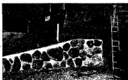
◎下室田町 擁壁の補修
