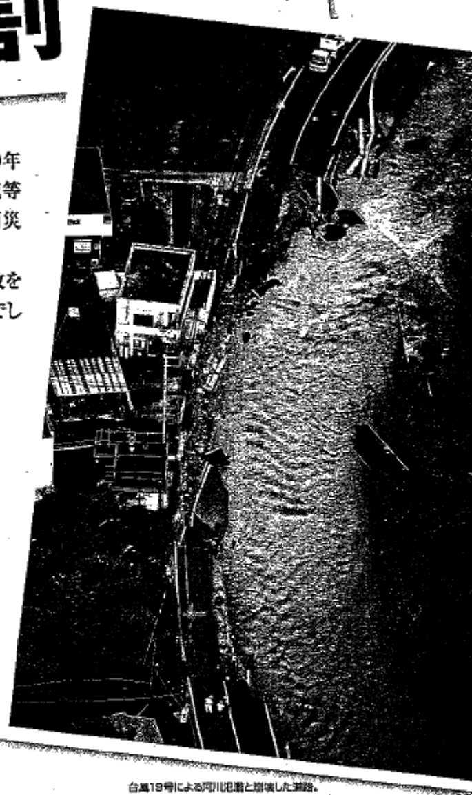
台風19号による河川氾濫と増壊した道路。 19年10月13日 東京朝日の出町(朝日新聞社/時事通信フォト)
