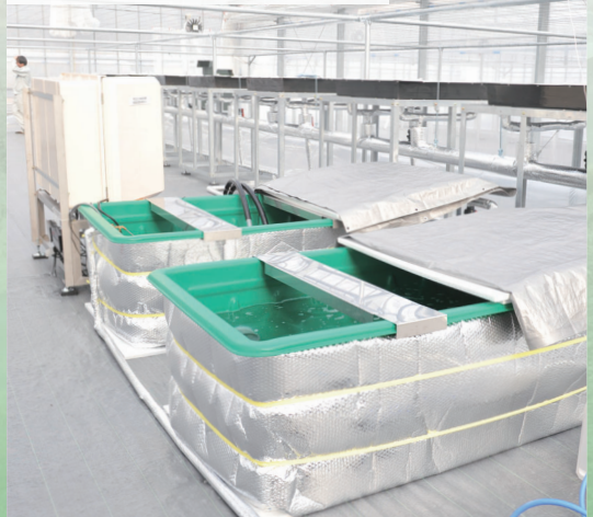
追肥や水温調節を行う液肥攪拌槽
