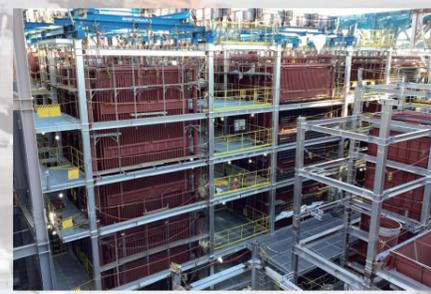
ごみを燃やす「焼却炉」と、その熱を利用して発電などに利用する蒸気を作る「ボイラ」
