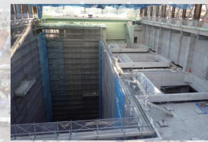
収集された可燃ごみを一時的に貯めておく「ごみピット」（左側）と、焼却炉への投入口「ホッパ」（右側）
