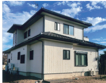
外壁を塗り直した住宅
