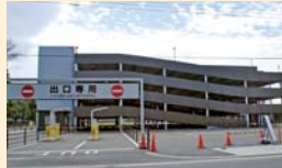
城南立体駐車場
