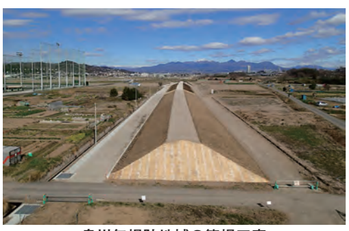
烏川無堤防地域の築堤工事
