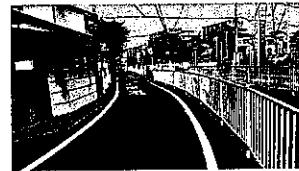
江木町 道路の補修
