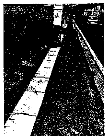
稲荷台町 側溝フタ設置
