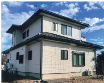
外壁を塗り直した住宅
