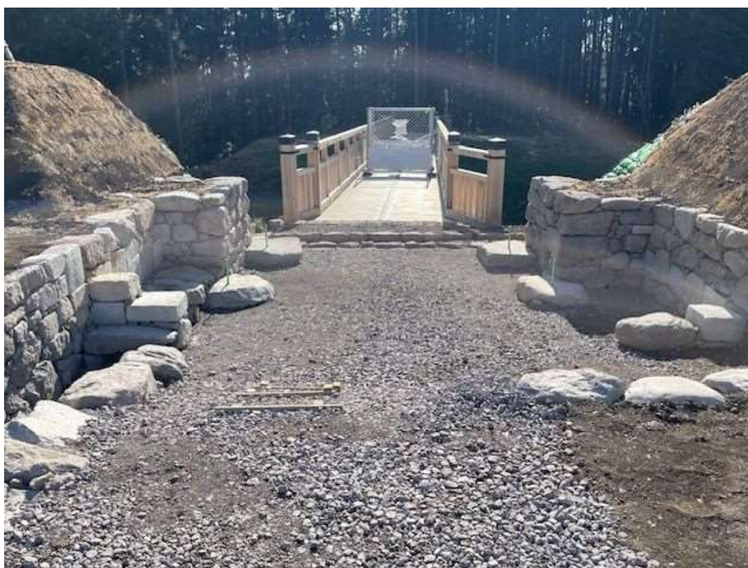
本丸西虎口整備工事箇所（完成後）
