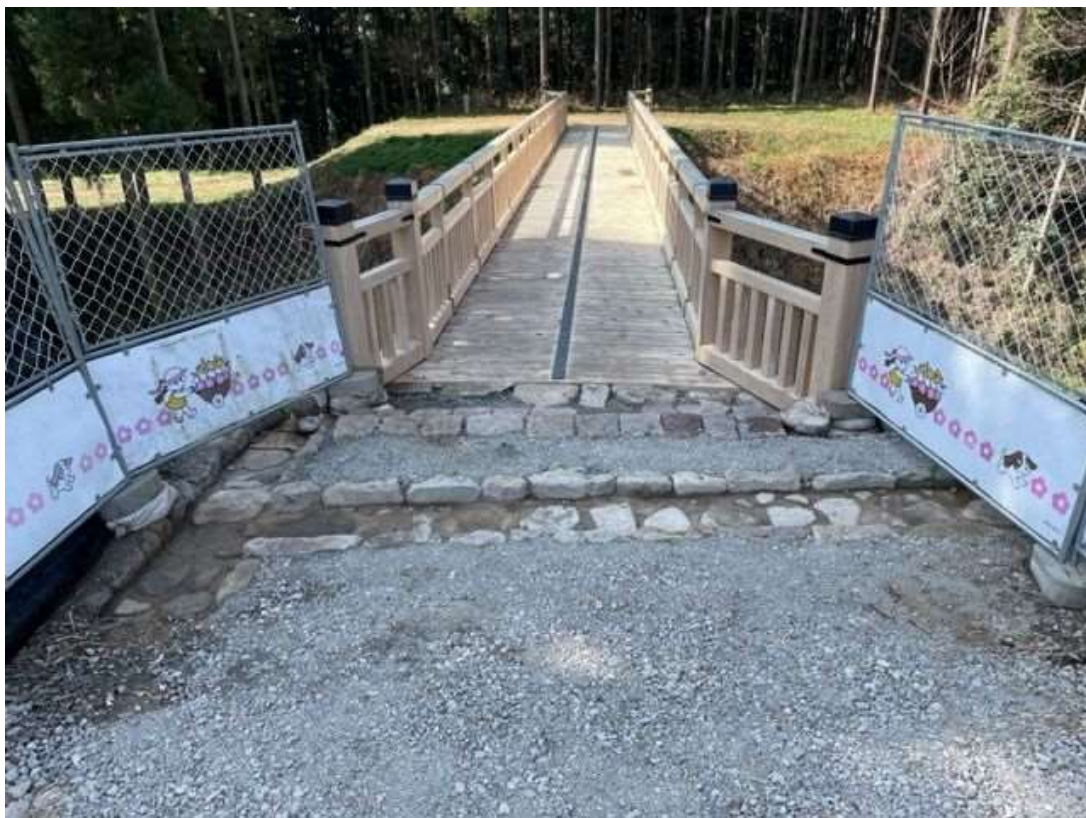
本丸西虎口整備工事箇所（着手前）
