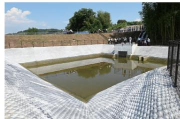
台風などの大雨時の浸水被害の軽減を目的に、ため池とポンプを備えた排水施設を吉井町吉井地区に整備しました。
