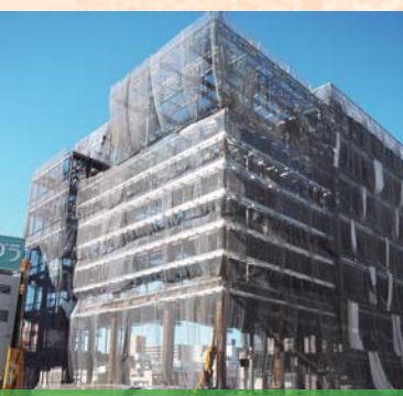
高崎駅西口に建設が進む大型商業施設
