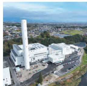
令和7年2月から稼働する新高浜クリーンセンター
