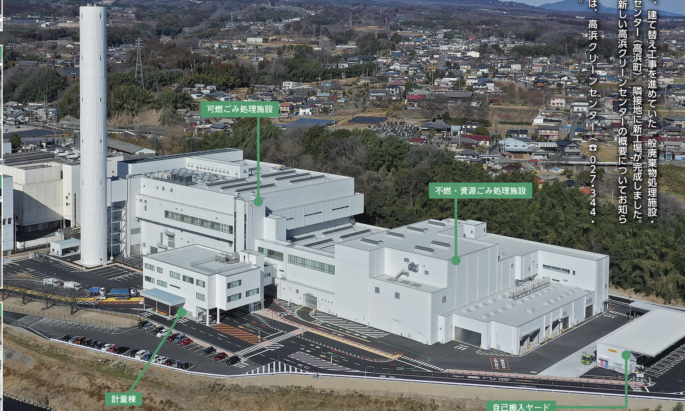
計量棟 入口の計量台を2台設置。ごみ収集業者と市民の搬入ルートに分けることで渋滞を緩和します
