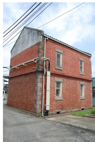
二階建煉瓦庫
