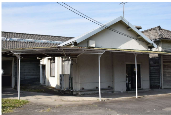
工務室 明治後期頃
