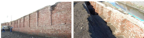
※ 温井川煉瓦造護岸擁壁
