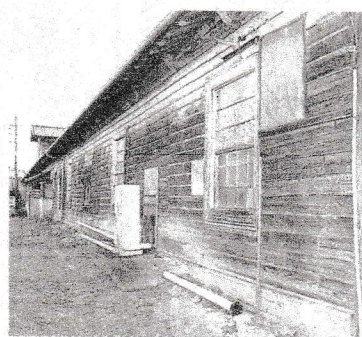
旧新町紡績所の工場 本館＝高崎市新町
