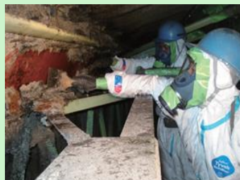
吹付け石綿の除去作業の様子
