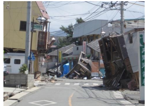
地震で損壊した建物
