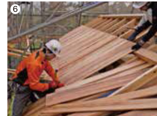
屋根は、手割りしたスギ板で葺き上げる。
