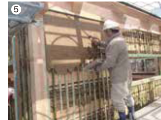
竹を格子状に組んで縄で固定した木舞 の上に荒壁を塗りこむ。
