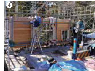
慎重に柱を立て、組み上げる。
