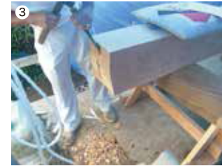
礎石上面の形状に合うように、柱を何度 も加工する(光付)。
