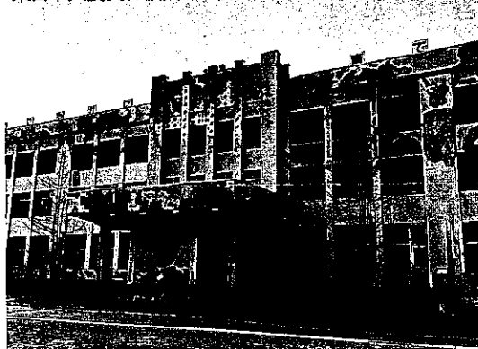
東日本大震災で被災した校舎
