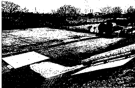
阿久津町排水施設（管内視察）
