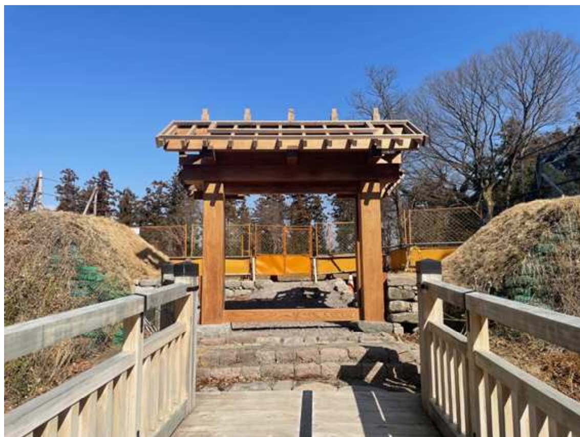
本丸西虎口門復元工事箇所（西から）
