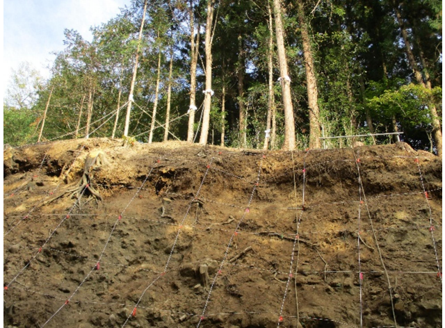
写真-4 現場施工状況②
