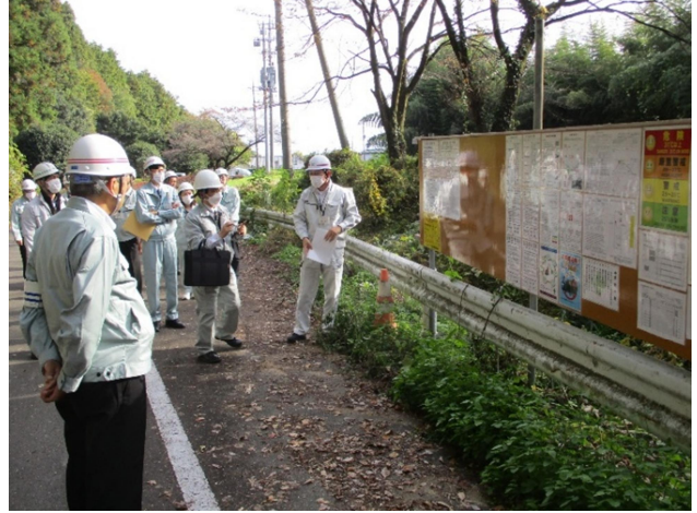
写真－8 工事看板設置状況
