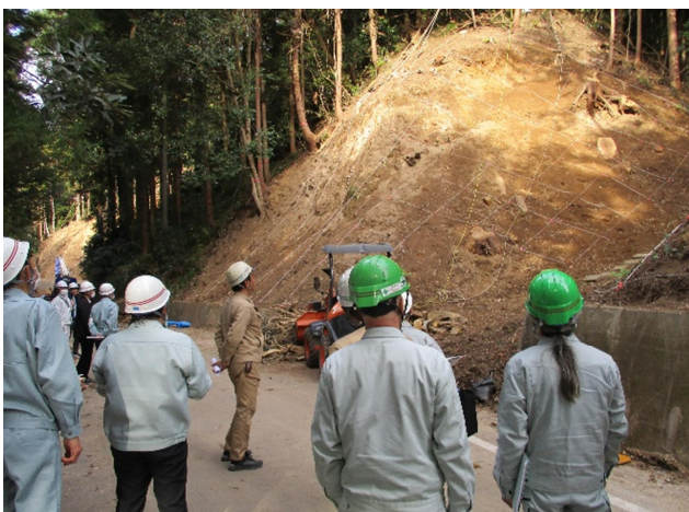
写真-5 現場施工状況③
