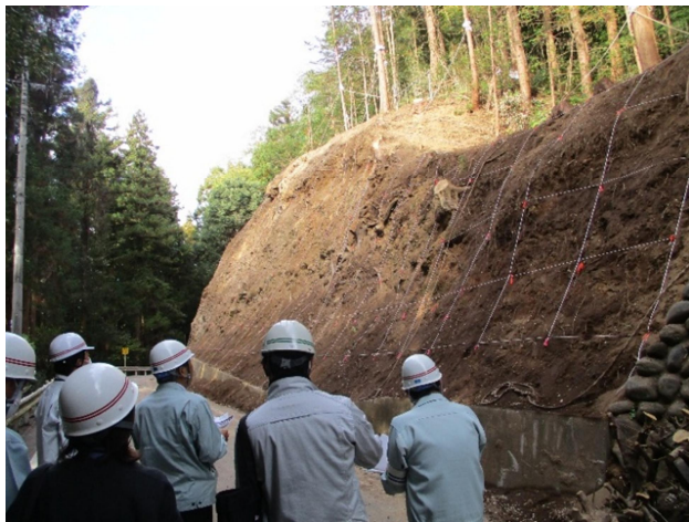
写真-3 現場施工状況①
