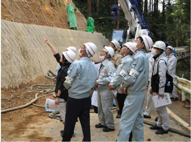
写真－7 現場施工状況⑤
