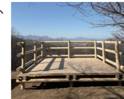
改修したウッドデッキ
