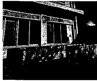
⑦中央公民館スロープ 外壁劣化により、安全確保のため使用停止中であつたが 落下防止対策（コーティング塗装）後、使用再開
