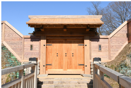
【最近復元された 本丸西虎口門】
