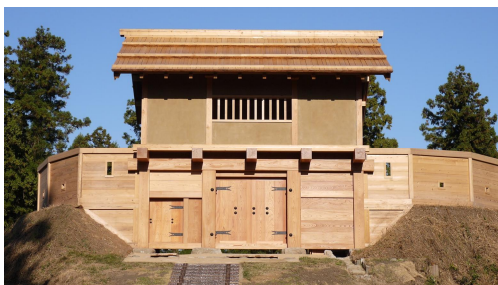
【平成28年に復元され た郭馬出西虎口門】
