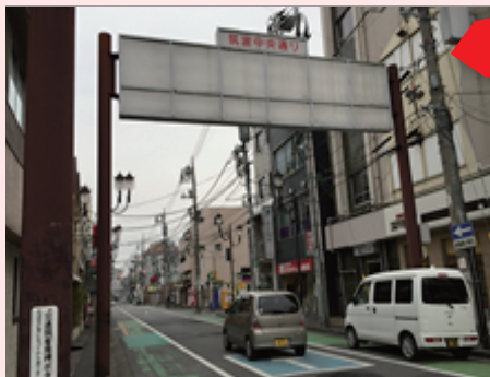
撤去されずに残されたアーチ看板
