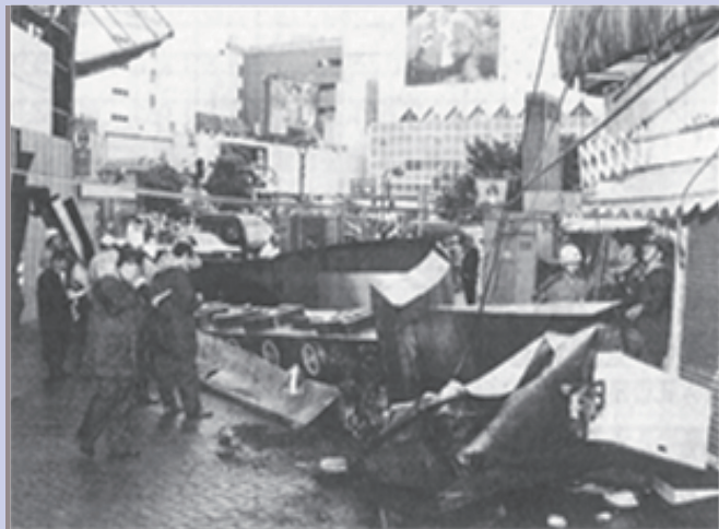
台風で落下した時の様子
