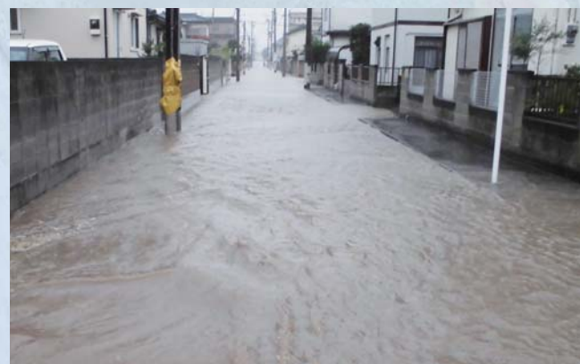
冠水した住宅地の道路。今回は側溝や用排水路の点検も強化
