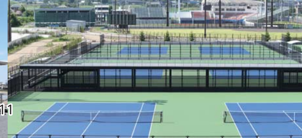
観覧デッキにはスロープも設置
