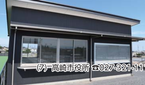
デッキ2階に設けた運営室
