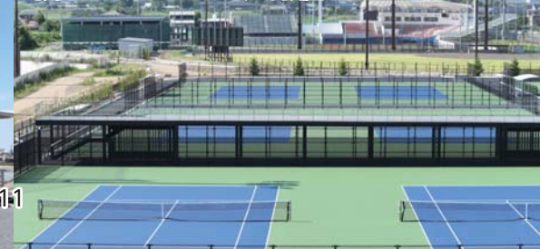
観覧デッキにはスロープも設置
