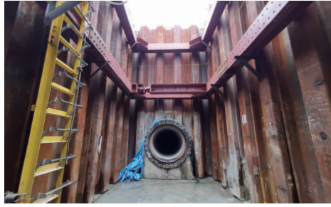
地下6mにある管の中を探検する
