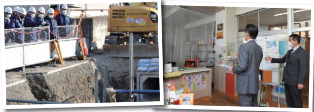
工事計画の進行や教室の使用状況などを確認
