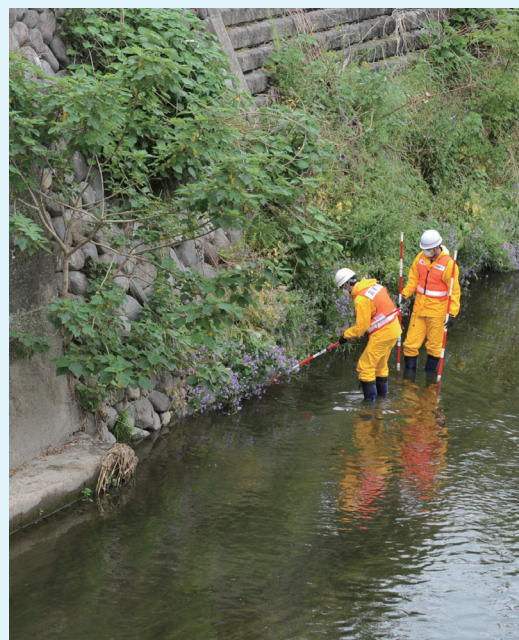
河川内の草や土砂の堆積を調査する職員
