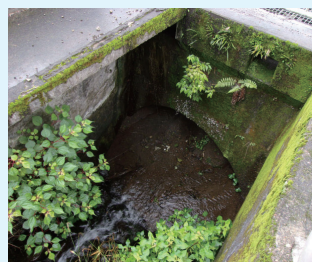
障害物の撤去などの対応を行う
