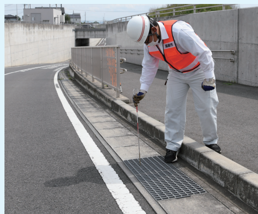
側溝に土砂が溜まっていないか点検
