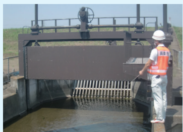
水門の詰まりなどを確認
