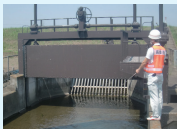
水門の詰まりなどを確認
