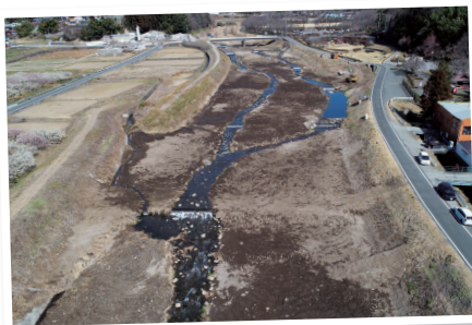
堆積した土砂を撤去した榛名白川
