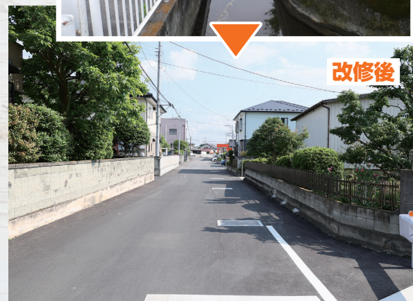
冠水対策を行った屋敷添水路(井野町)。道路のかさ上げを実施。水路は拡張して地中化し、道路を広げて通行できるようにしました
