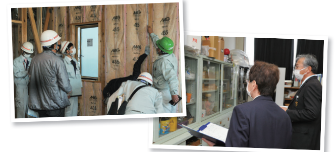
安全に工事が行われているかや教室の使用状況などを確認
