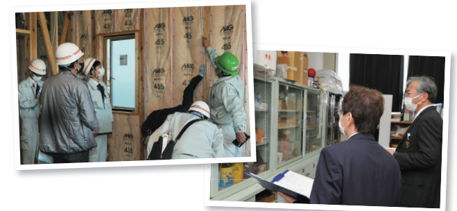
安全に工事が行われているかや教室の使用状況などを確認
