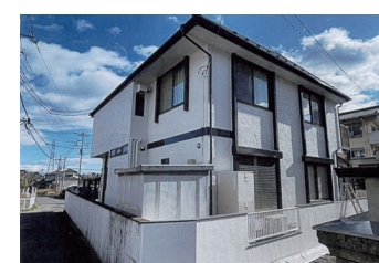
外壁を塗り直した住宅
