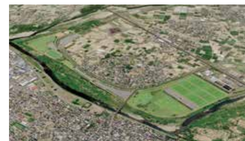
さまざまなスポーツが楽しめる施設を高崎市民ゴルフ場跡地に整備
