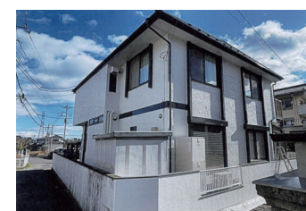
外壁を塗り直した住宅
