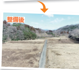
重機を入れて木の伐採から整地までを行った農地
