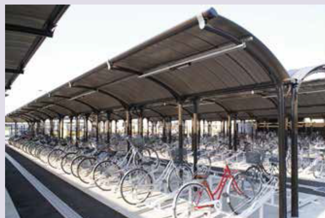
問屋町駅東口自転車駐車場
