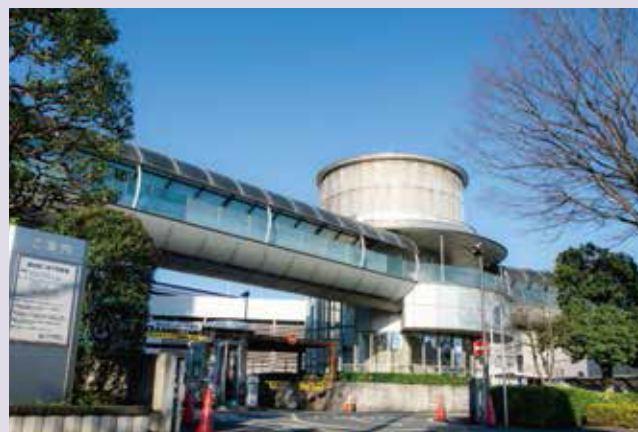
城址第二地下駐車場
