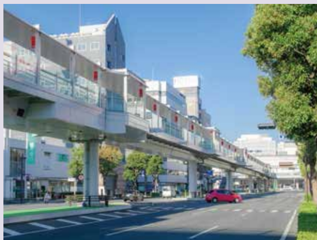
高崎駅東口線 高崎駅東口3号線（ペDESTリアンデッキ）
