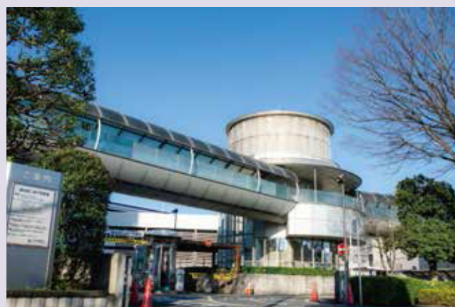
城址第二地下駐車場
