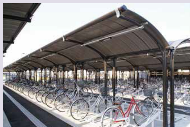
問屋町駅東口自転車駐車場
