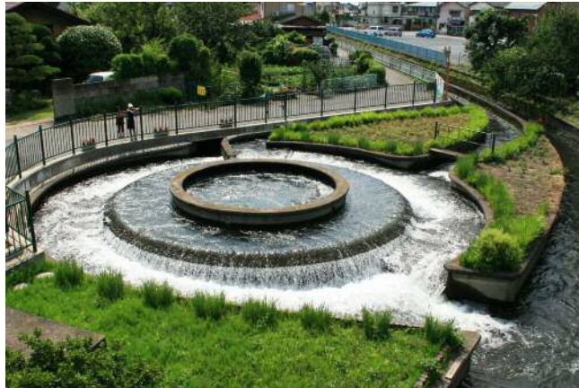
長野堰用水円筒分水堰
