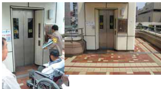
エレベーター「誘導ブロックがない」
