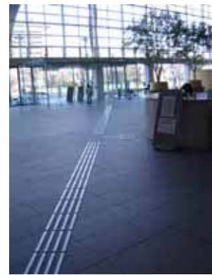
誘導ブロックと 床の色が似てい て見分けにくい （公共施設）
