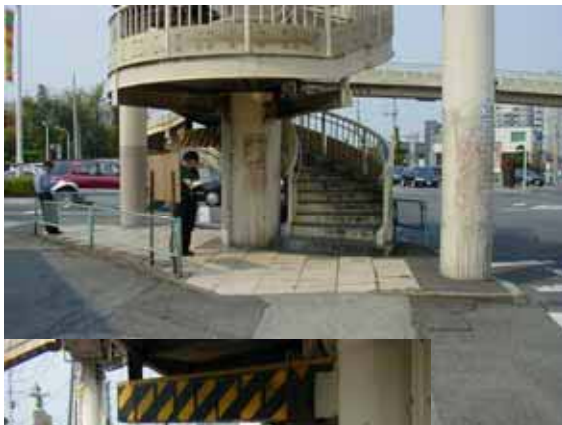
歩道橋 「車イスでは渡れない」
