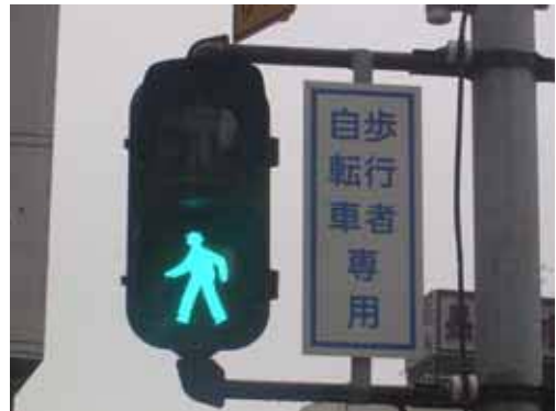
見やすい信号機を設置した事例 (歩行者用信号機)
