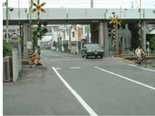
センター間を結ぶ道路 「踏切があり、歩道がない」
