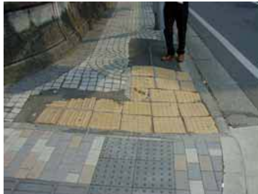
歩道のこう配、誘導ブロック「歩道が斜め、また、ブロックの仕様がかわっている」
