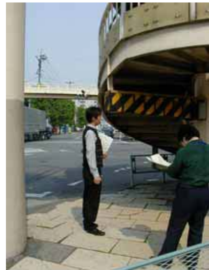
歩道橋下 「階段下のスペースに余裕がない、視覚障害者は危ない」
