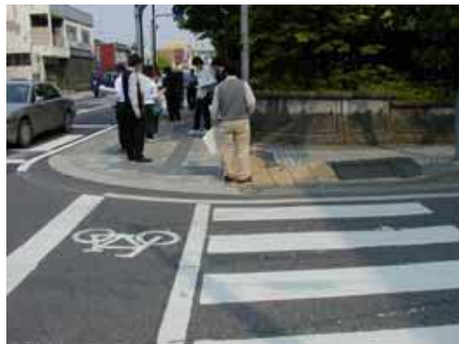
歩道のこう配、誘導ブロック「歩道が斜め、また、ブロックの仕様がかわっている」
