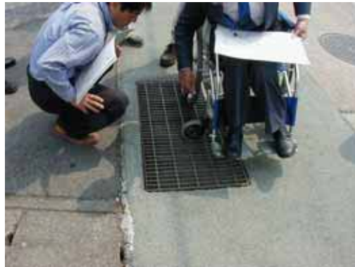
柵「前輪が引っかかり走りにくい」
