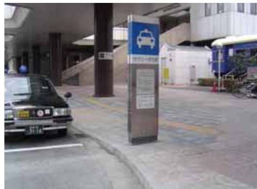
西口タクシー乗場の段差の解消と誘導ブロックの黄色化を実施
