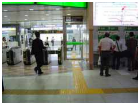
視覚障害者や車イス使用者に配慮された直線的で幅の広い（90cm以上）改札
