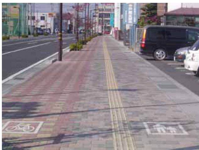
黄色い誘導ブロックと自歩道を区分した道路の事例
