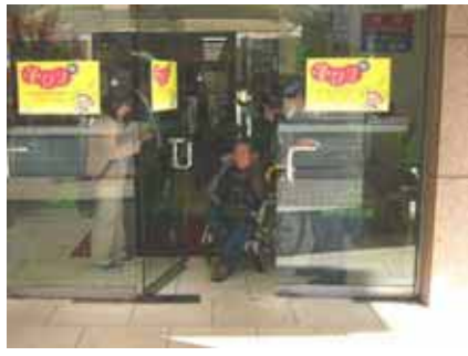
入口が自動ドアではないため 車イス使用者にとっては開閉 が困難（商業施設）
