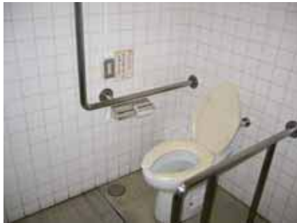
多目的トイレが設置されて いるが、手すりが固定式で使 い勝手がよくない （商業施設）
