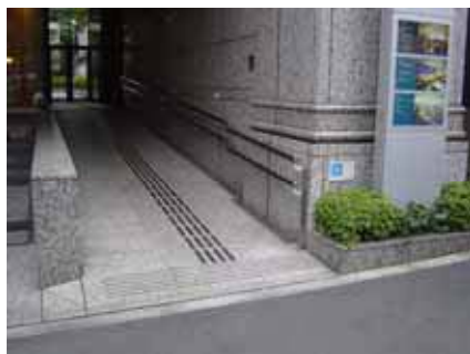
道路との段差をスロープにより解消した建物の事例
