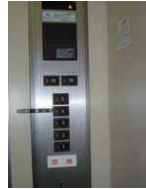
エレベーターの ロビー及びカゴ 内に点字表示が ない（公共施設）
