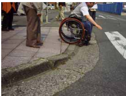
道路の点検風景「こう配がきつい」
