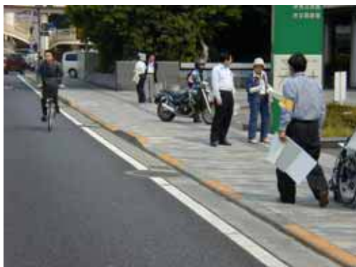
図書館の入口「歩道が波打っている」
